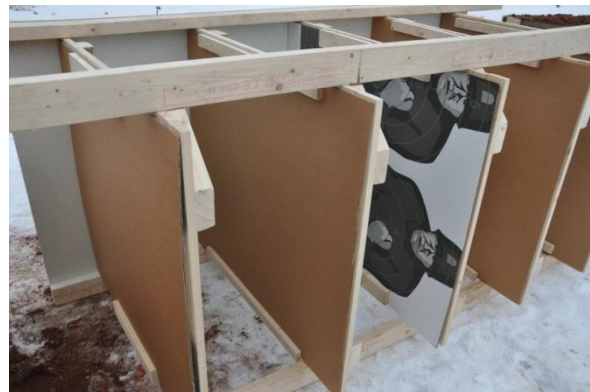
Figur 1-9 Luftspalt med vittnesskivor i papp var 0,50 m. Bakom vittnesskivorna vitmålad bakgrund för att erhålla optimal kontrast vid höghastighetsfilmning.
