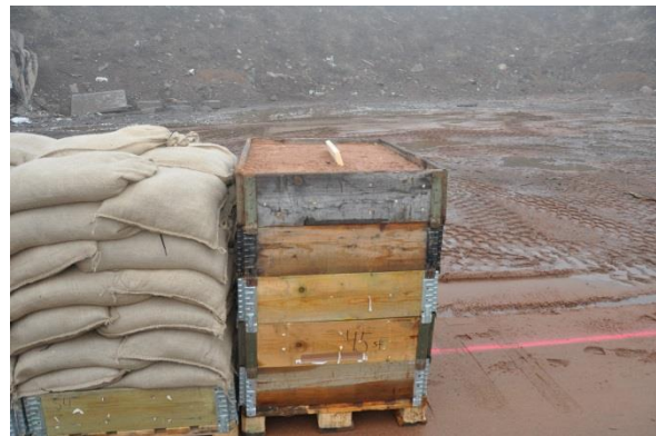
Figur 1-14 Bakom sandsäcksbarriären anbringades ett extra uppfång/mothåll fyllt med sand.
