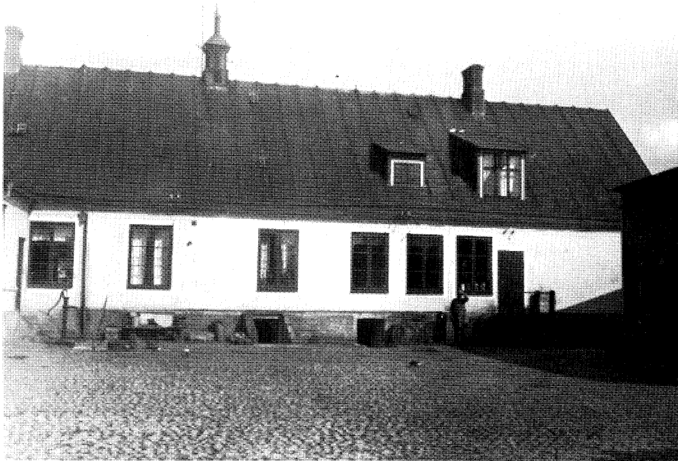
Per Mörcks gård före ombyggnaden på 1920-talet.
