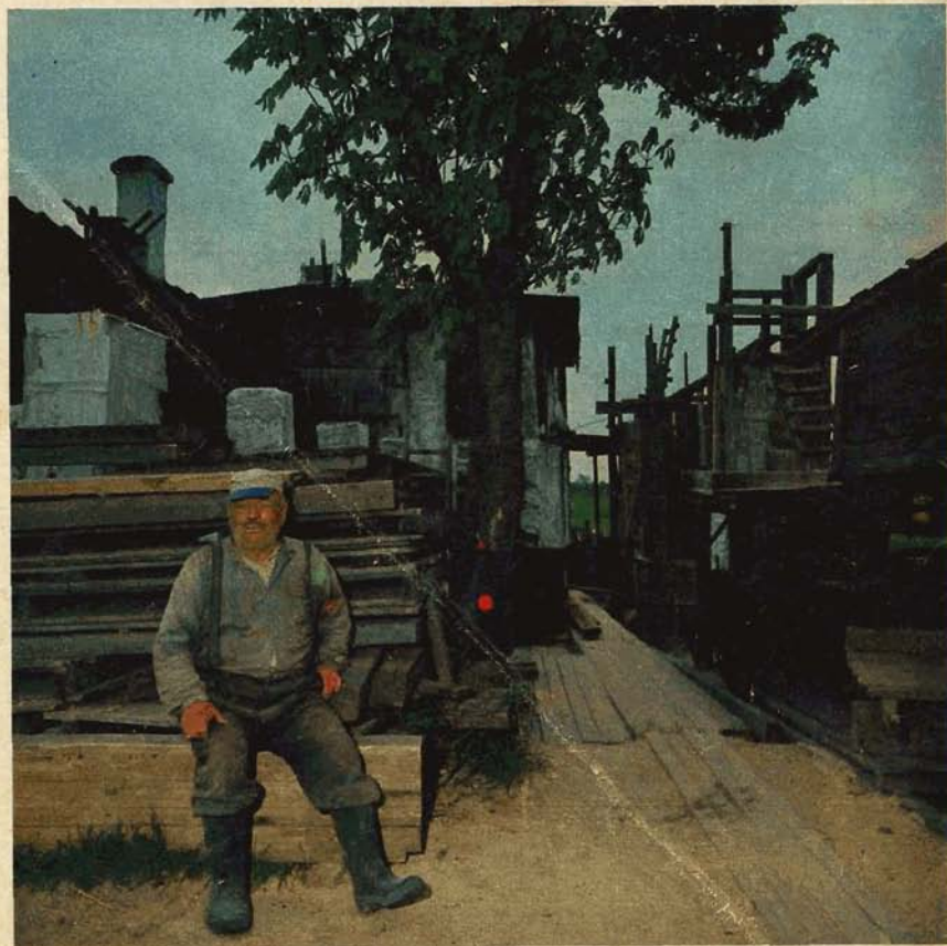
En vilopaus måste man ta vid mina år, säger Karl-Göran Persson. I bakgrunden pekar nybyggets järnvägsräls rakt upp från de blivande betongpelarna.
