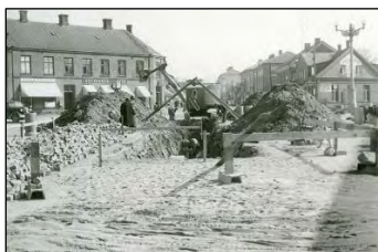
Gamla Torg vid nedläggning av nya avloppsrör.
