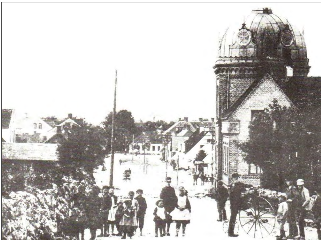
Storgatan sedd från öster. Backen ner kallades Tornbacken.
