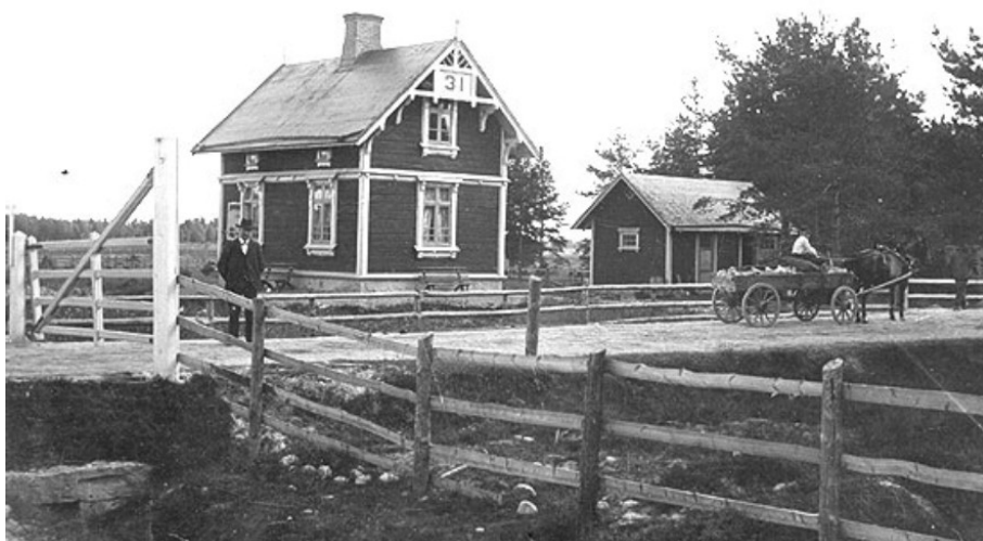
Banvaktstuga vid Borås-Alvesta järnväg (BAJ).
