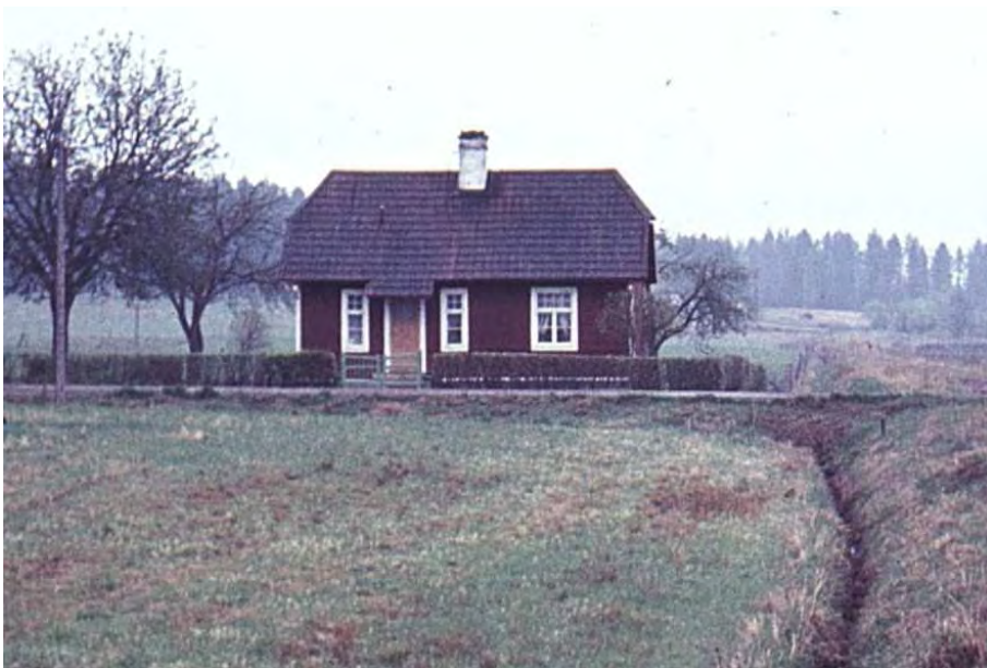
Banvaktstuga vid Enköping-Heby-Runhällens järnväg (EHRJ).
