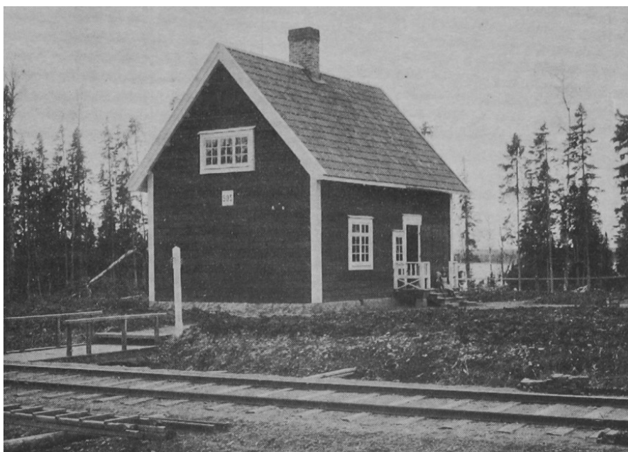
Banvaktstuga 505 Svartviken på SJs Inlandsbana mellan Jämtlands Sikås och Hoting. Denna stuga har bara ett sidoljusfönster vid sidan av dörren istället för två som var vanligast. Foto från »Teknisk-ekonomisk redogörelse för [...] statsbanan Östersund-Ulriksfors [...]« (1917).
