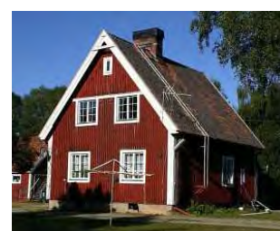
Den kombinerade banmästar- och banvaktstugan i Lövberga vid SJs Inlandsbana. Foto Peter Sandström
